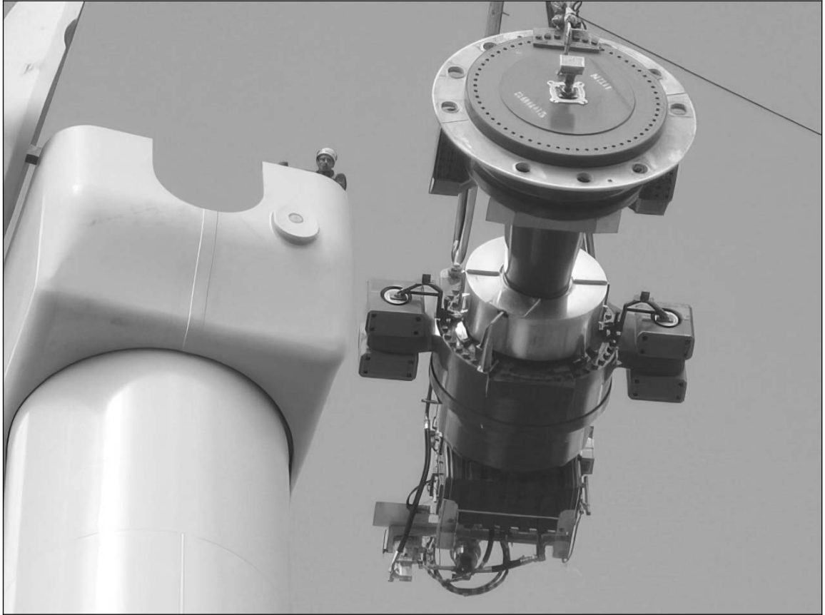
Montage des Antriebsstrangs einer Windkraftanlage. Quelle: Paul Anderson, CC BY-SA 2.0 42
